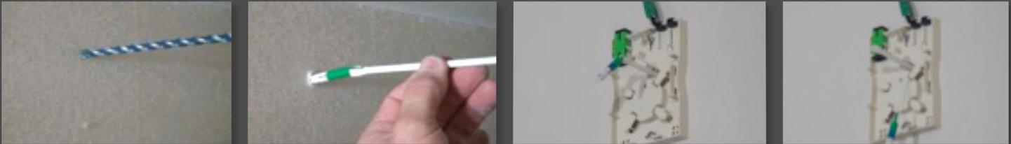
**4.5.2** Assemblez la prise du connecteur au connecteur (fournie avec les bobines) et branchez-le au module puis au connecteur externe. La prise du connecteur doit être ajustée dans la bonne position comme montrée ci-dessous. Nettoyez et branchez le connecteur à l'adaptateur afin de connecter le InvisiLight™ au module d'entrée de la fibre
