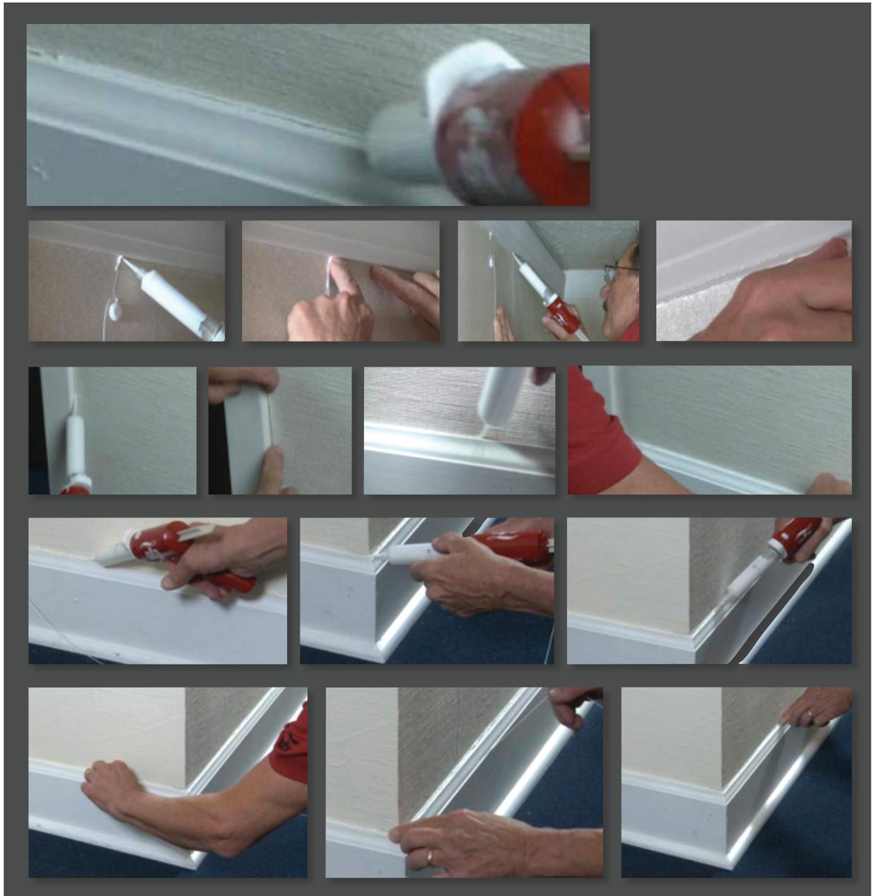
**4.6.2** Pour les coins, assurez-vous que la fibre soit déjà préinstallée sur des cornières. **SI LES CORNIÈRES NE SONT PAS PRÉINSTALLÉES, ARRÊTEZ LE PROCÉDÉ, PLACEZ LES CORNIÈRES MANQUANTES ET REPRENEZ L’INSTALLATION DE LA FIBRE. SI LA FIBRE PASSE PAR DES CAVITÉS, CONSERVEZ UN ANGLE DE 5 MM.**
